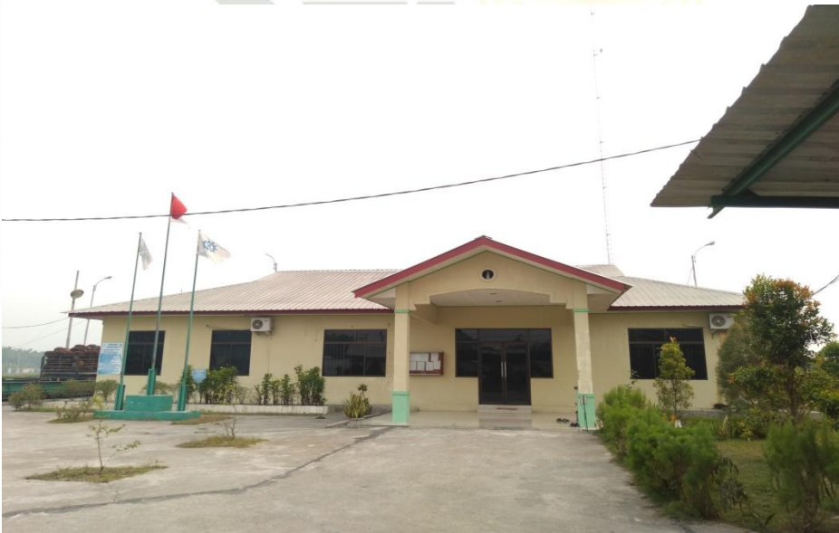
Kantor PT. Riau Agri tampak depan
