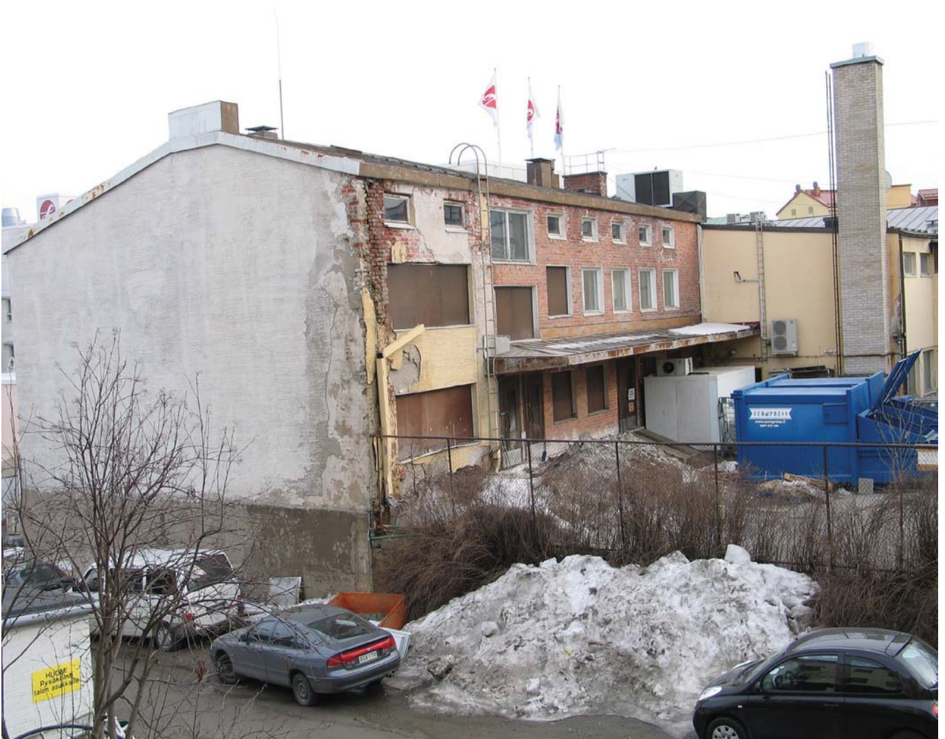
Kuva 1. Näkymä korttelin 9 sisäpihalle Valtakatu 24 parvekkeelta.
