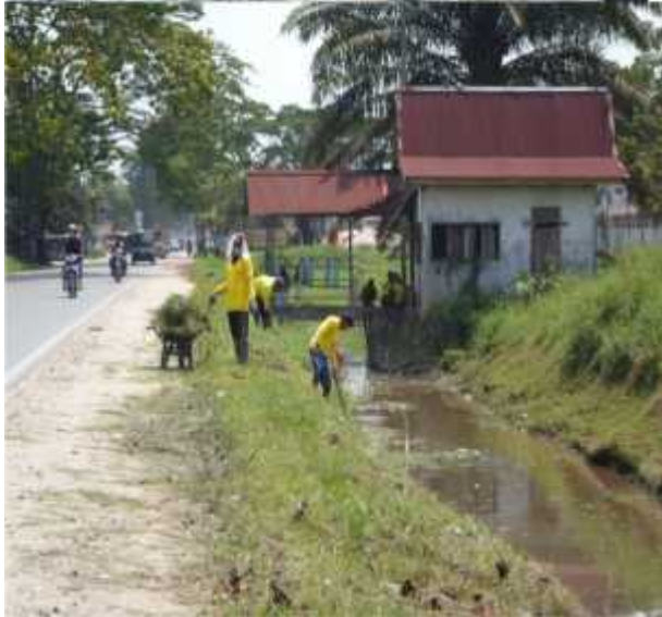
Dinas PU yang bertugas membersihkan drainase di jalan-jalan protokol
