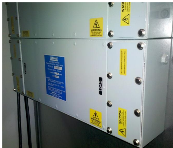
Figura 4.57: Filtros EMI alimentación cámara anecoica
