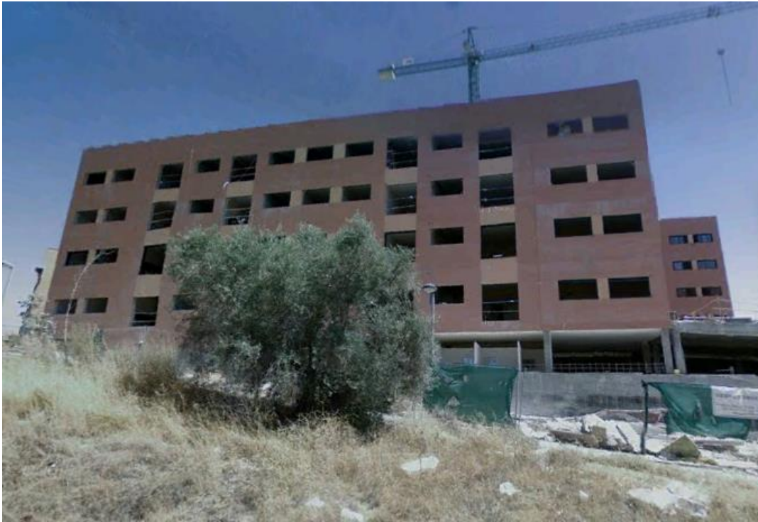
Figura 2. Vista del edificio
