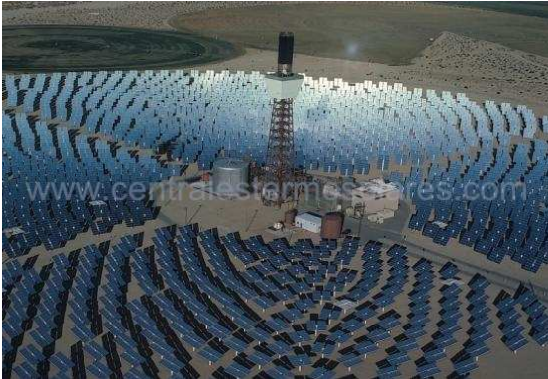
Figura 86. Vista de una torre y su campo de helióstatos.
