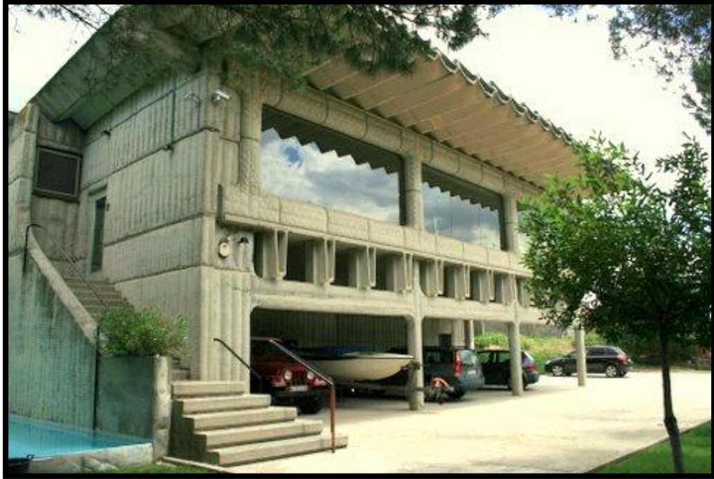
Figura 5. Fachada principal con orientación Sur
