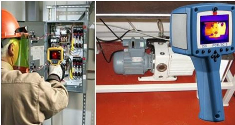
Ilustración 41: Inspección mediante cámaras termográficas.
