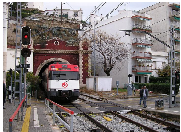
Figura 2.4. Paso a nivel.
