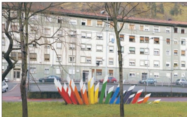
FIG. 19. Una barriada marginada desde su inicio, con fuertes problemas constructivos, debido a las prisas con las que se levantaron los bloques en la carretera antigua de Langreo a Mieres, a unos tres kilómetros del centro de esta ciudad, consiguió a mediados de los años ochenta, no sólo una rehabilitación solvente de las fachadas de los edificios, sino también de las viviendas y, sin que lo pensaran nunca, un parque, levantado sobre una pequeña escombrera, en la entrada de la barriada según se viene de Mieres. Todo se debió a un Plan de Rehabilitación Integral impulsado por el entonces consejero competente, Emilio Murcia, en cuyo honor pusieron su nombre al fallecer éste prematuramente. Es de poca entidad superficial, y los elementos florales son todavía muy discretos, no así su cromatística ornamentación escultórica.
