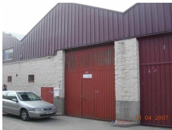
*Fig. 2.22: Disposición de puerta metálica en muro piñón de la nave*
