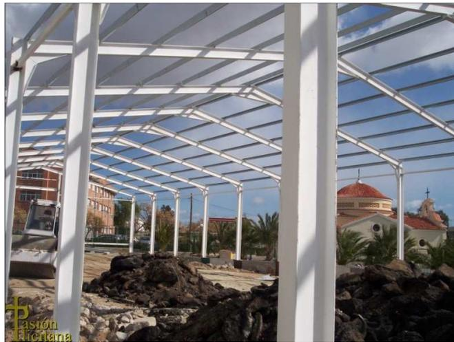
*Fig. 2.1: Ejemplo de estructura metálica con correas en cubierta y cartelas*
