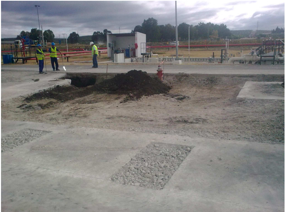
Figura 63. Comienzo de la excavación en la zona de bombas MBP-7/8
