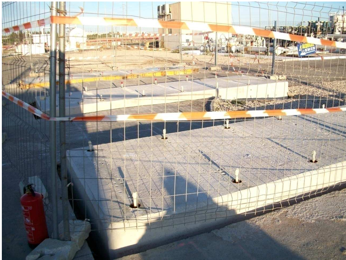
Figura 68. Cimentación de las bombas MBP-12/22/32
