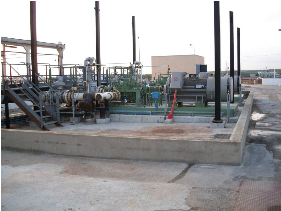
Figura 66. Zona de bombas MBP-7/8 con la cimentación finalizada
