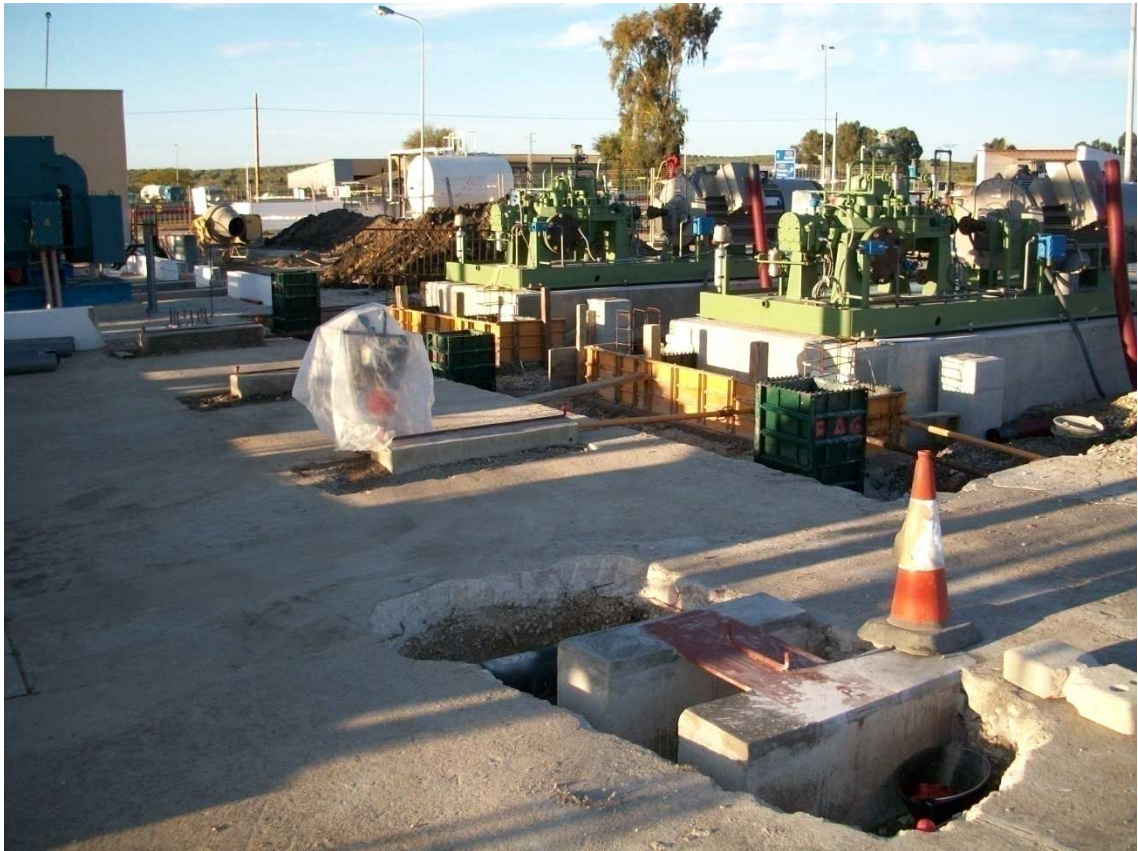
Figura 64. Encofrado de la bancada de la bomba MBP-8 y posterior acoplamiento de las bombas a sus respectivas bancadas.
