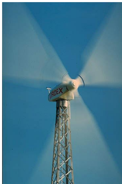
Figura 2.36: Aerogenerador con torre de celosía
