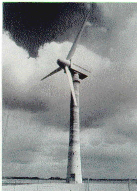
Figura 2.33: Aerogenerador tripala. Tjaereborg (DK), 61 m Ø, 2MW, 1988
