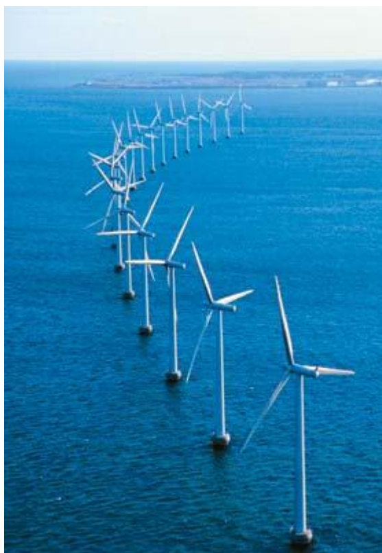
Figura 2.16: Parque Eólico en Copenhague: 20 aerogeneradores de 2 MW ubicados formando un arco
