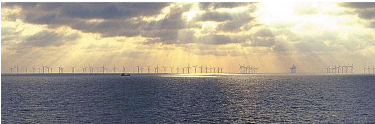
Figura 2.16: El parque eólico más grande de Dinamarca: 80 turbinas de 2MW
