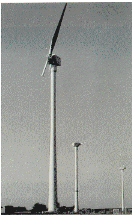
Figura 2.35: Aerogenerador monopala, 56m Ø, 640 kW. 1990
