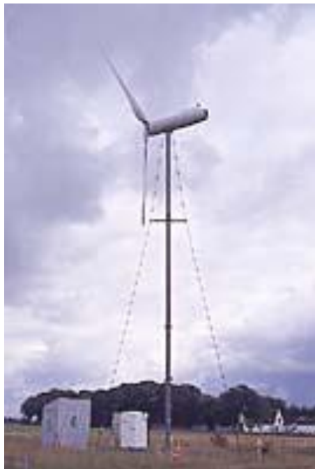
Figura 2.38: Torre tubular de acero atirantada
