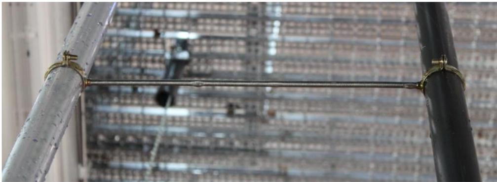
*\*Figura 4.19: argollas con varilla roscada.*
