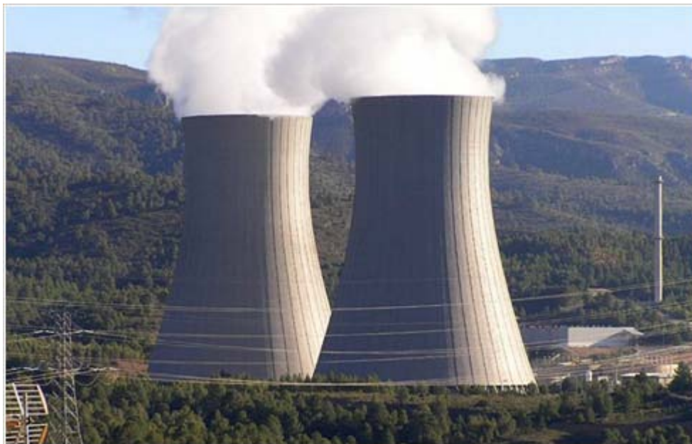
Figura 3-5, torres de refrigeración evaporativa (obtenido de eco.microsiervos.com ).
