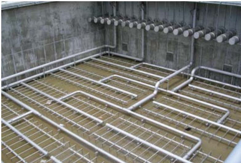
Figura 2-11, sistema de aireación de burbuja gruesa (obtenido de www.retema.es ).
