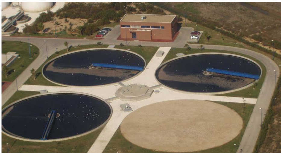
Figura 2-6, decantadores PTAR de San Fernando (obtenida de www.sanfernando.es ).
