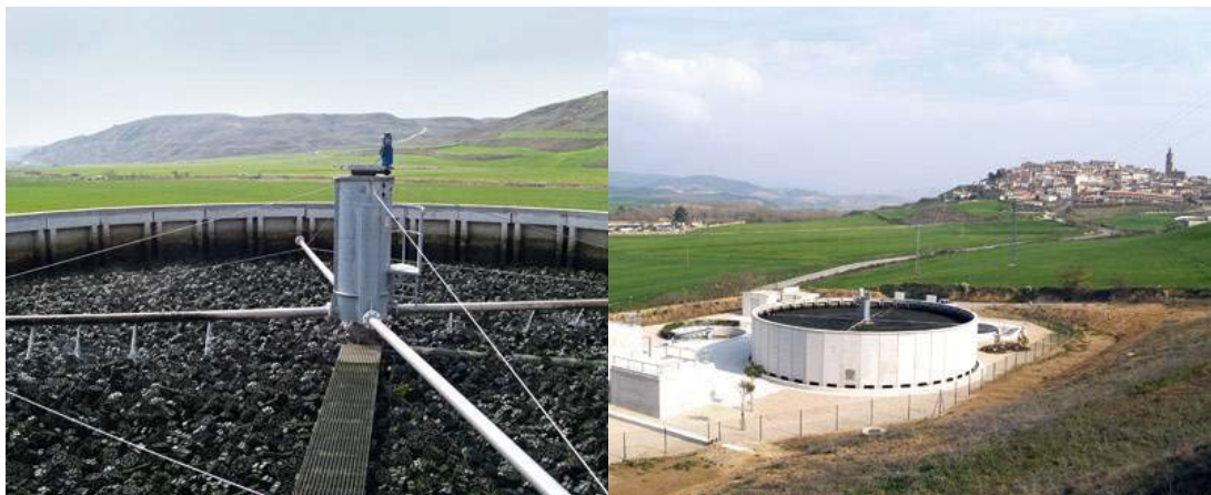
Figura 2-12, lecho bacteriano con soportes de plástico (obtenido de www.nilsa.com ).
