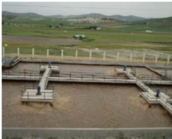
Figura 2-10, cuba de aireación (obtenido de www.juntadeandalucia.es ).
