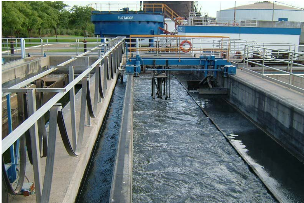
Figura 2-4, desarenador rectangular, (obtenido de prueba2.aguapedia.org).
