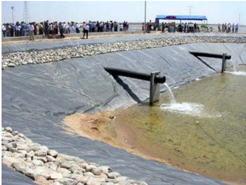
Figura 2-9, laguna de oxidación (obtenida de educasitios.educ.ar).
