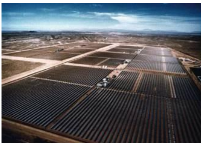
Ilustración 7: Centrales SEGS, en Mojave, California.
