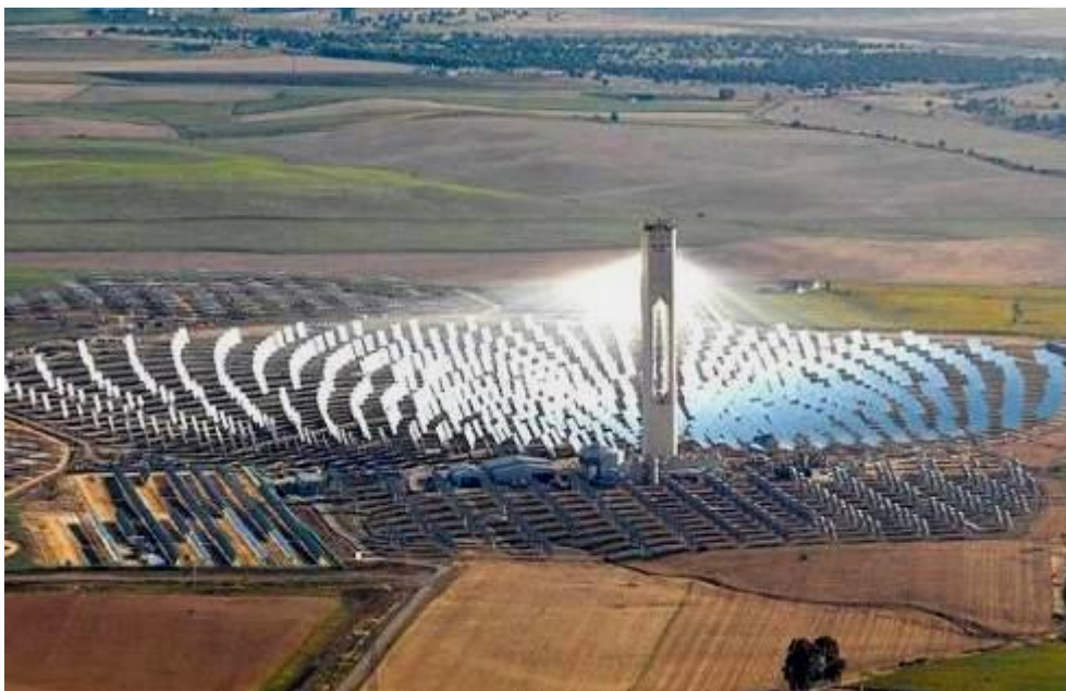
Ilustración 25: Toma frontal de receptor central.
