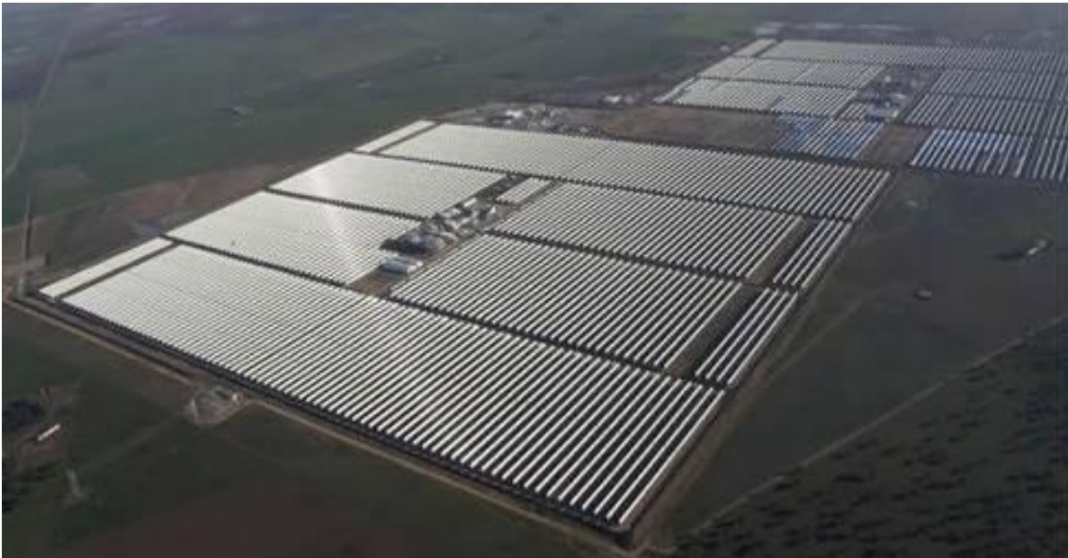
Ilustración 15: Extresol 1, de ACS-Cobra. (al fondo puede observarse Extresol 2 en construcción avanzada)
