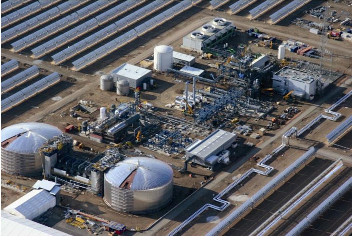
Ilustración 35: Isla de potencia con sistema de almacenamiento.
