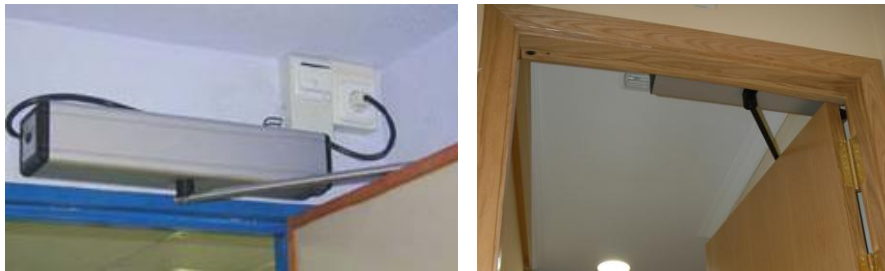
Imagen 8. 4 - Ejemplo de colocación de automatismo para la apertura de puertas abatibles, [19]
