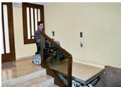
Imagen 8. 2 - Rampa mecánica para salvar las escaleras de entrada
