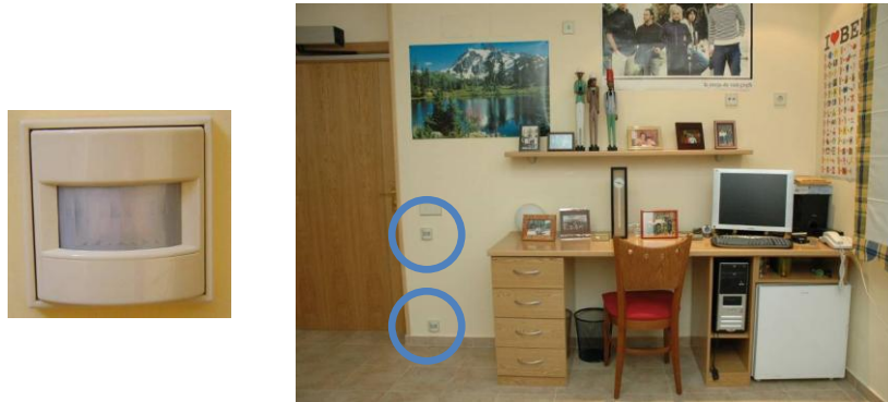
Imagen 8. 5 - Ejemplo de colocación de sensores de detección de caídas en la habitación, [19]
