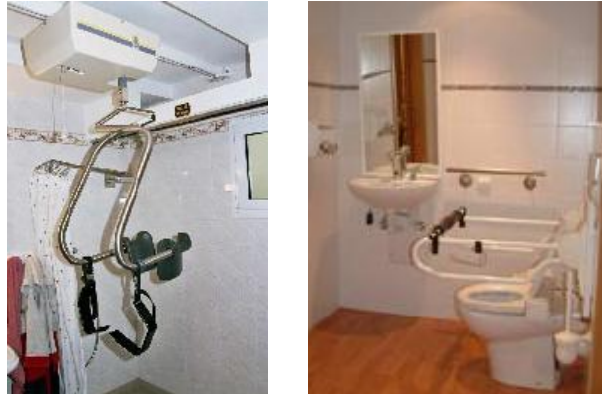
Imagen 8. 21 - Grúa de transferencia (izquierda) y ejemplo de aseo adaptado para discapacitados (derecha), [19]
