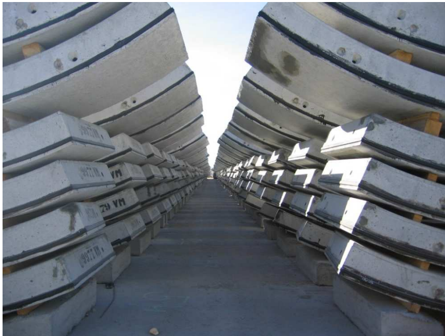
Figura.3.3.4.3: Imagen del acopio de dovelas para los túneles de Guadarrama.
