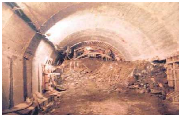
Figura 3.1.5: Excavación y hormigonado de los hastiales [1].
