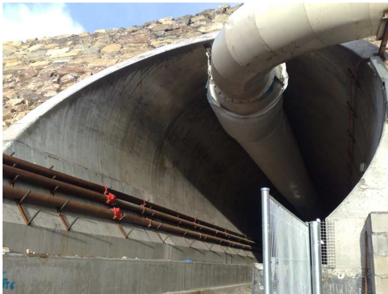
Figura 1.- Emboquille Túneles de Pajares (Lote 1), Pola de Gordón (León)
