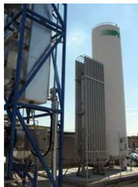
Figura AI.5. Depósito principal de nitrógeno líquido de la Universidad Carlos III de Madrid.
