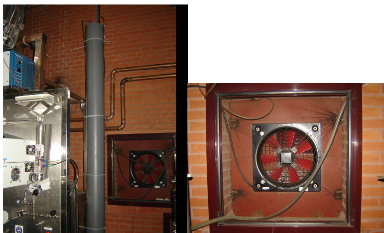
Figura 4.14 a) Depósito de agua y b) extractor de aire.
