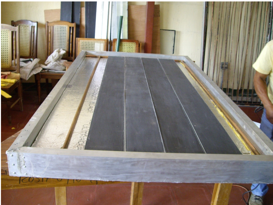
Figura 8.4 Foto de la construcción del colector
