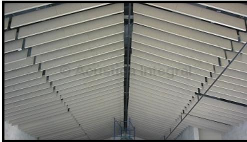
Fig. 55: Ejemplo de Acondicionamiento de Techo. (Fuente: Acústica Integral S.A.)
