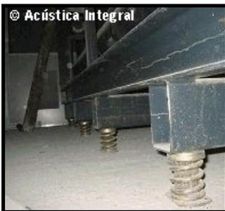
*Fig. 43: Resortes Aislantes de Vibraciones.*
