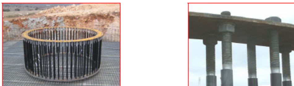
Figura E.9. Colocación de plantilla y tuercas II
