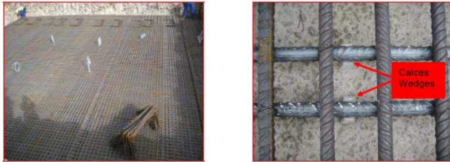
Figura E.3. Armado de parrilla y calces
