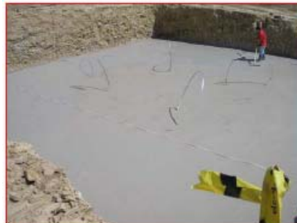
Figura E.2. Red de tierras y hormigón
