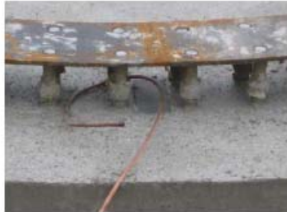
Figura E.11. Nivelado de placas
