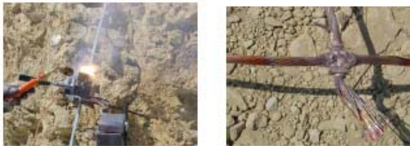
Figura F.10. Soldadura
