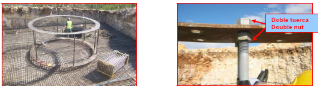
Figura E.8. Colocación de plantilla y tuercas I
