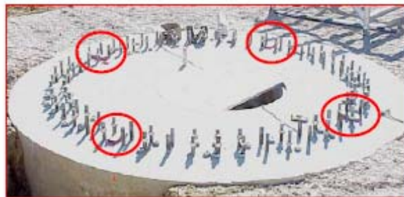
Figura E.14. Apilado de chapas de nivelación
