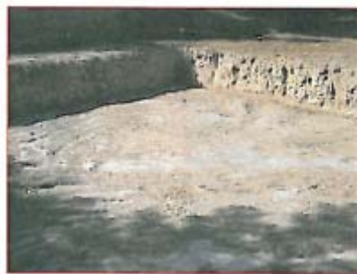
Figura E.1. Fondo de excavación
