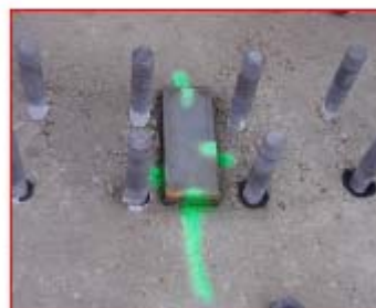
Figura E.15. Marcado de posición de chapas
