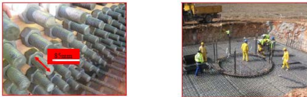
Figura E.7. Colocación de pernos de la jaula
