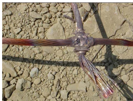
Figura F.7. Unión de anillos con prolongaciones con unión aluminotermia
