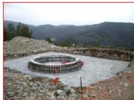
Figura E.12. Comprobación entrada y salida de cables
