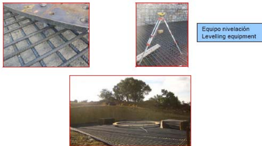
Figura E.6. Nivelado de brida de cimentación
