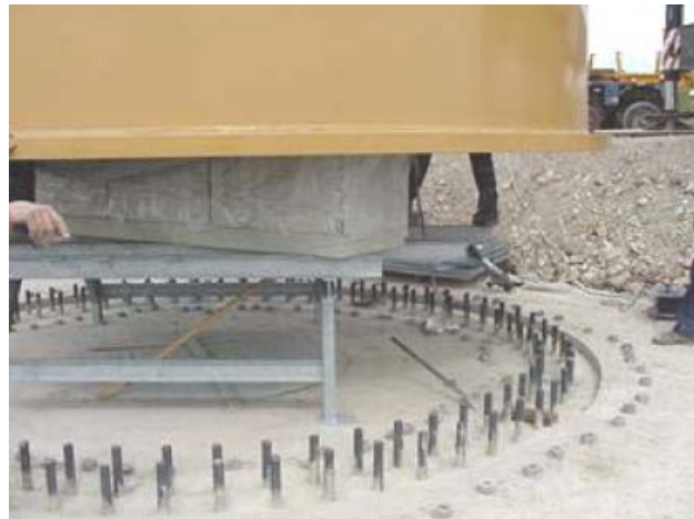
Figura 3.11. Vista de las hileras de pernos durante el montaje
