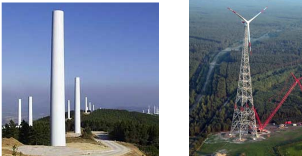
Figura 3.8. Torre de acero tubular (izquierda) y torre de celosía (derecha)
