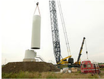
Figura 3.9. Izamiento de torre tubular de acero
