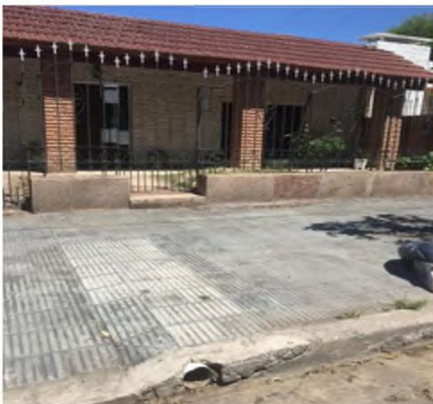
Imagen 9. Viviendas de material. Córdoba, Argentina. Agosto. 2018.
