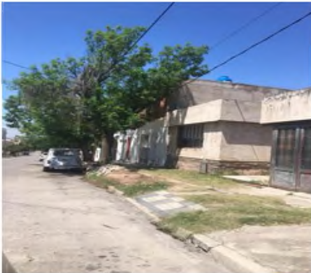
Imagen 11. Veredas en mal estado. Tendido eléctrico. Córdoba, Argentina. Agosto. 2018.
