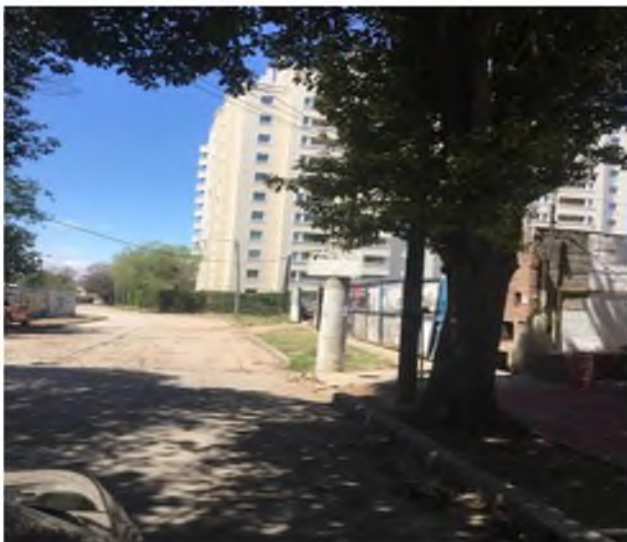
Imagen 15. Escombros provenientes de obras en veredas. Asfalto en mal estado. Córdoba, Argentina. Agosto. 2018.
