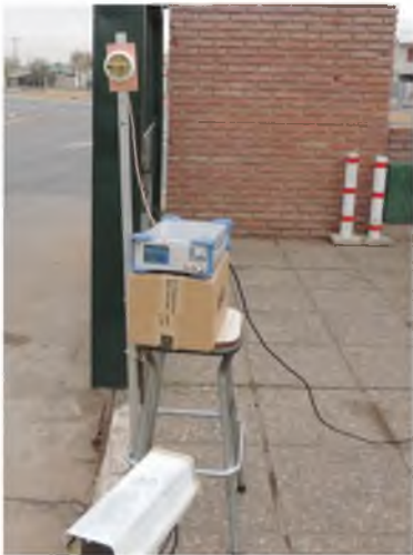
Fig 4.5.2.3 – Montaje de equipo emisor, enlace outdoor 600 m.
