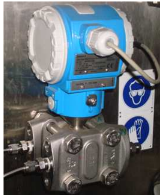
Figura 3.11. Sensor diferencial de presión indicador de nivel.
