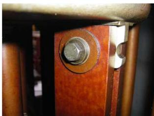
**Figura 4.22. Holgura en el anclaje de las barras del selector a la estructura**
