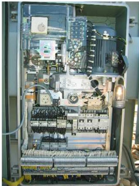
**Figura 2.7. Armario de accionamiento y mando [2]**
