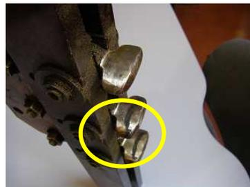
**Figura 4.26. Contactos fijos del selector desgastados**
