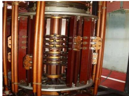
**Figura 4.25. Barra de anclaje del selector partida**
