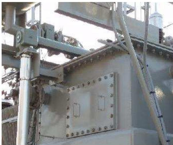
**Figura 2.12. Boca de hombre para la inspección del selector en cambiadores de tomas internos.**
