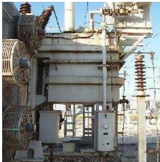
**Figura 2.11. Cambiador de tomas en carga externo**
