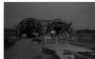
Slika 8.- Primer tunela građenog u otvorenom
