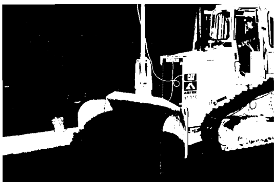
Slika 5. Brana Platanovrissy: sistem razastiranja i zbijanja
