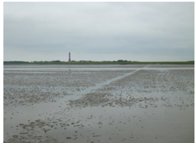
Abbildung 6 Kabelschlitz im Sandwatt ca. 6 Wochen nach Kabellegung bei Norderney (Foto: Schumann 2014)
