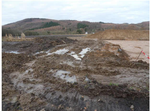
Bild 1: Bodenschäden auf einer landwirtschaftlichen Fläche neben einer Baustelle.
