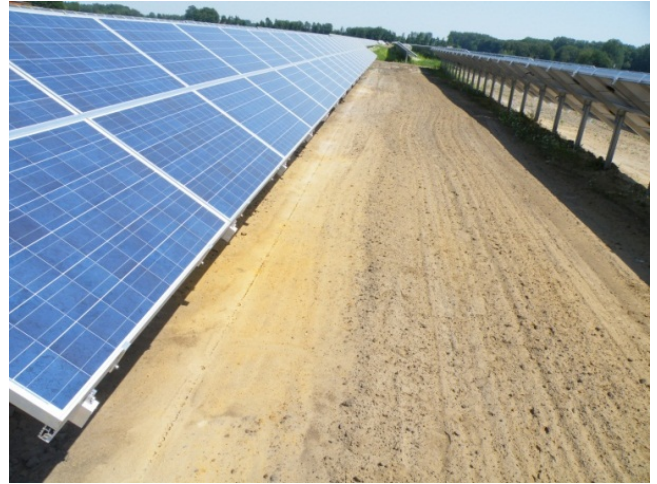
Abb.1: PV-Module nach der Installation auf einer Ackerfläche
