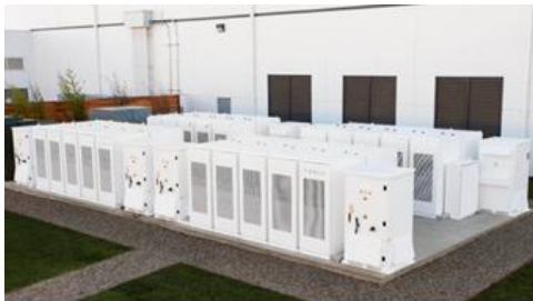
[Tesla – Powerpack System] - 단위용량 50kW/100kWh - ESS모듈 5대당 PCS 1대 구조
