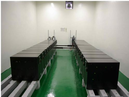
[그림 4] 설치된 리튬이온 전지
