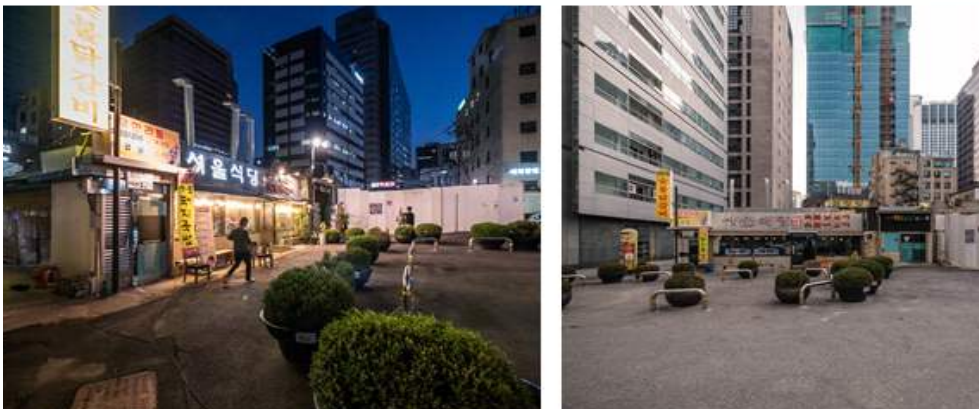
그림 96 대상지 주변의 전경, (좌측부터 시계방향) 대상지에 비치된 도로부지 알림판, 을지로3길 방향을 바라본 전경, 서울식당을 바라본 전경, 대상지의 전경.
