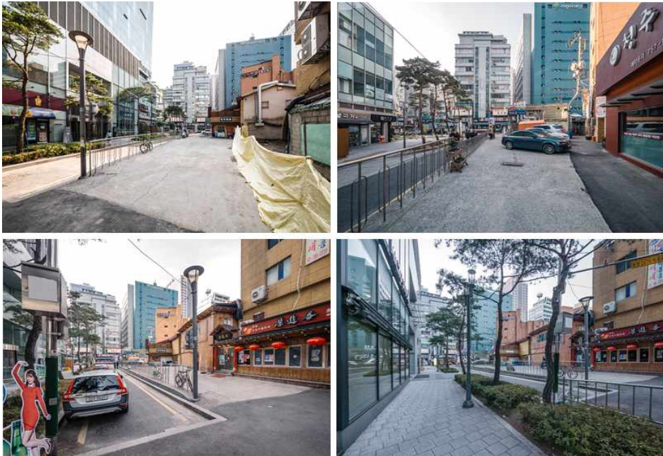
그림 79 대상지 주변의 전경, (좌측상단부터 시계방향) 제1공공공지 구역의 전경, 주차장으로 사용되는 공공공지, 7지구의 대지안의 공지의 경계를 만드는 담장과 식재들, 끊긴 도로와 불법주차 사진
