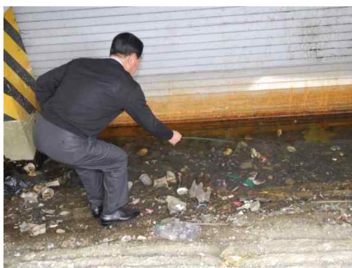
▲ 지하 침수로 악취, 해충 발생
