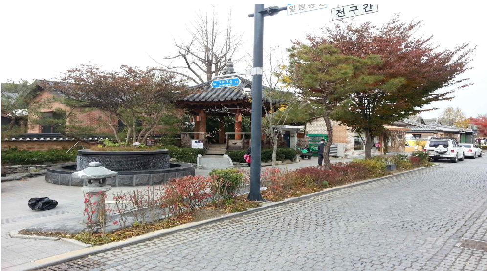
그림 11 2013년 은행로 공사 후 모습
