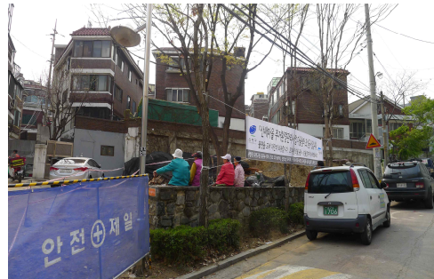
자료 : 다음 로드뷰 [그림 3-37] 공사 중인 마을 마당
