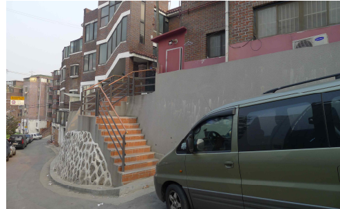
자료 : 직접 촬영 [그림 3-17] 담장 쌓기 및 필로티 정리
