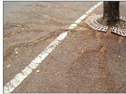
자료: 오마이뉴스(2010,06,18) “아스팔트에 숨막힌 나무 뿌리” [그림 4-18] 양버즘나무의 뿌리 용기로 파손된 바닥 포장
