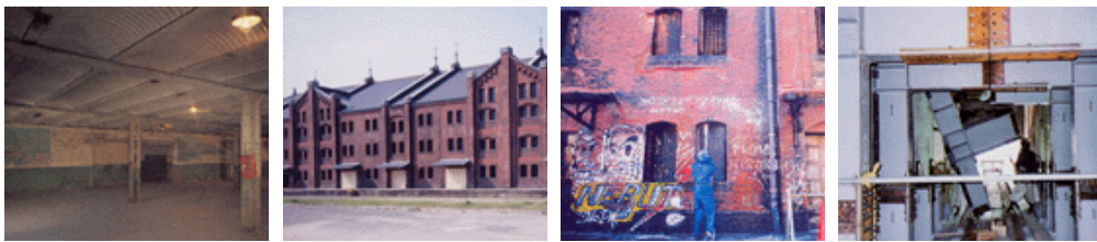
<그림2-7> 요코하마 적벽돌 창고의 과거 및 개보수과정 자료출처 : 요코하마 항만국 미나토 활기 진흥부
