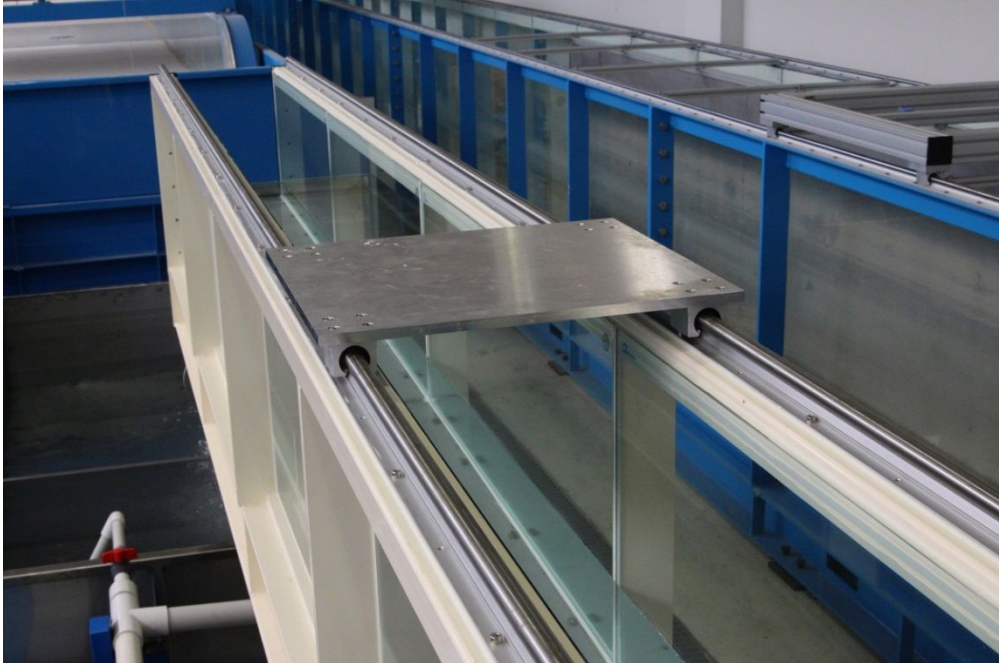
그림 3.10 수로위에 설치된 레일과 대차
