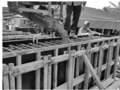
(d) Concrete pouring
