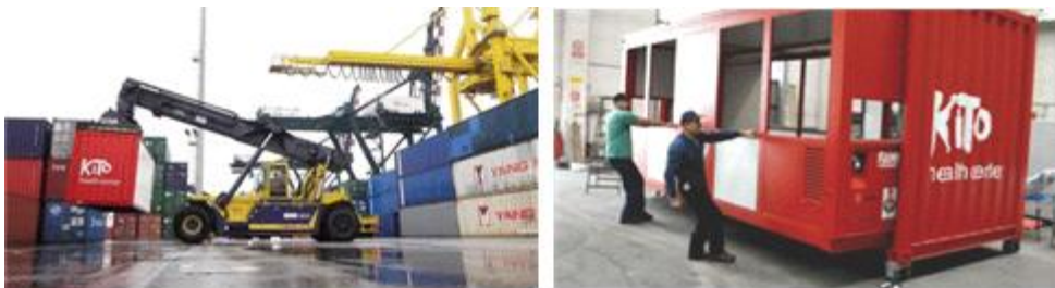
[그림 3-23] Kito-Hut 운송 및 설치과정 ( http://divisare.com/projects/201048-paola-vecchiato-kito-emergency-unit )
