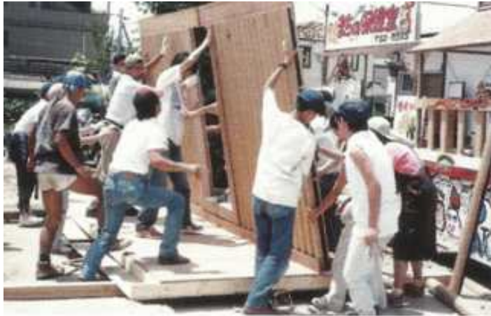
[그림 3-12] 일본의 종이튜브형 임시주거시설 설치과정 (출처: Ban, S., 외 7인 (2015). Shigeru Ban: Humanitarian Architecture. Aspen Art Museum.)
