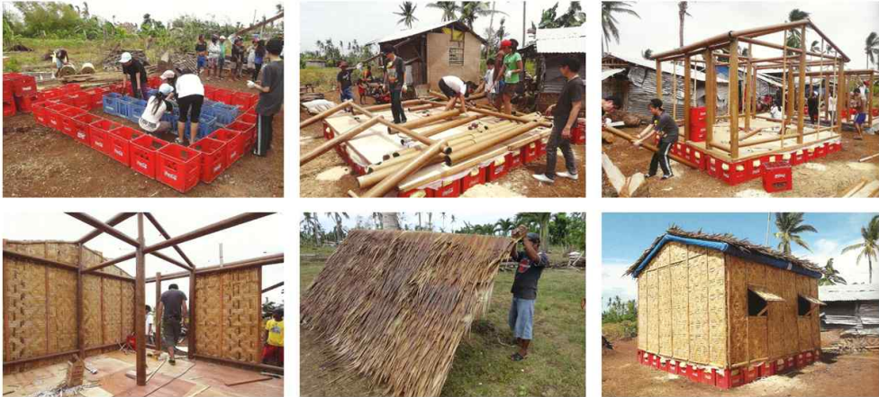
[그림 3-16] 필리핀의 종이튜브형 임시주거시설 외관 및 설치과정 (출처: Ban, S., 외 7인 (2015). Shigeru Ban: Humanitarian architecture. Aspen Art Museum.)
