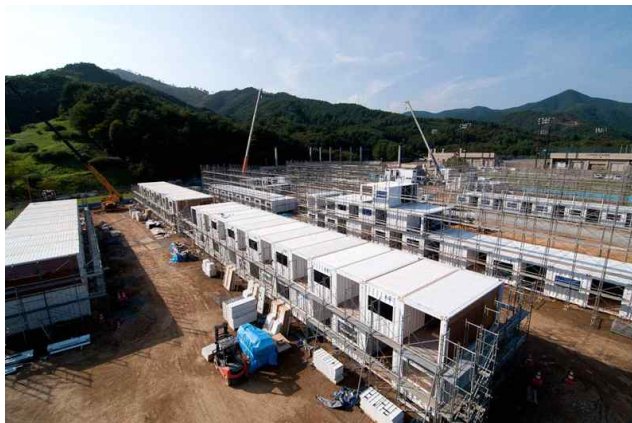
[그림 3-18] 주거유닛 설치과정 (출처: Ban, S., 외 7인 (2015). Shigeru Ban: Humanitarian architecture)
