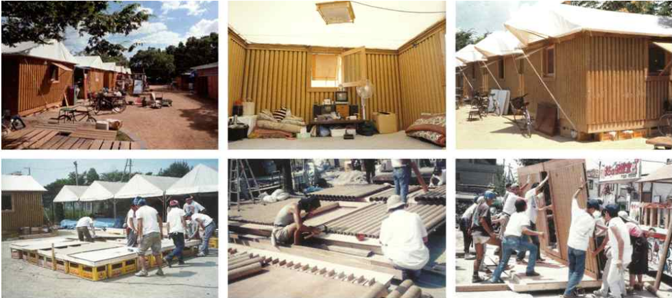
[그림 3-13] 일본의 종이튜브형 임시주거시설 설치과정 및 외관, 내부 (출처: Ban, S., 외 7인 (2015). Shigeru Ban: Humanitarian architecture. Aspen Art Museum.)
