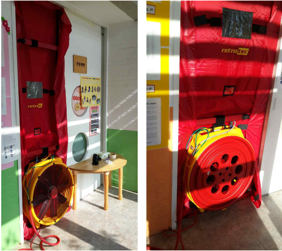
[그림 4.1] 대상 보육실의 Blow door test
