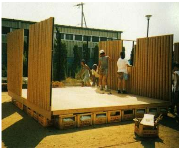
그림 29 Paper Log House-Kobe, construction view.
