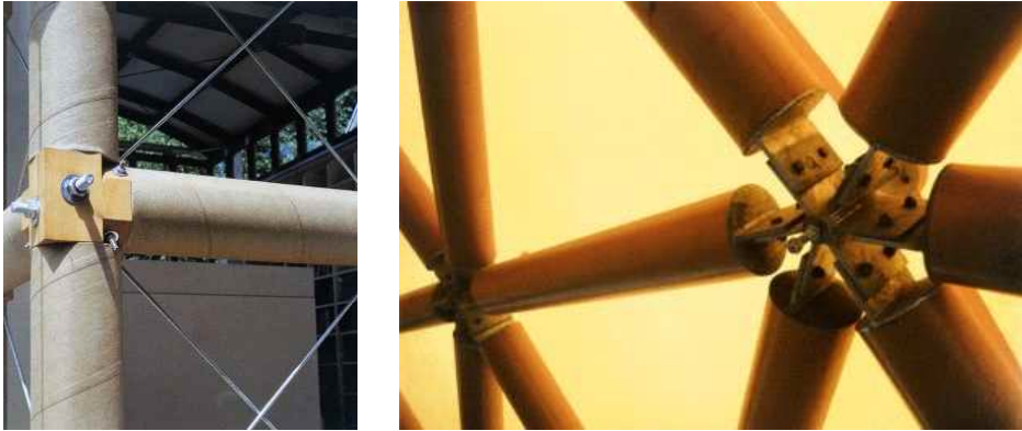
그림 15 Library of a Poet(Left)와 Nomadic Paper Dome(Right)의 종이튜브 접합 디테일. 시계루 반은 종이 튜브를 접합하는 방식에 대해 목재, 금속, 플라스틱과 같이 조인트 부재의 재료를 다양하게 실험하였으며, 조인트 부재의 종류에 따라 각기 다른 표현 방식으로 이어진다.
