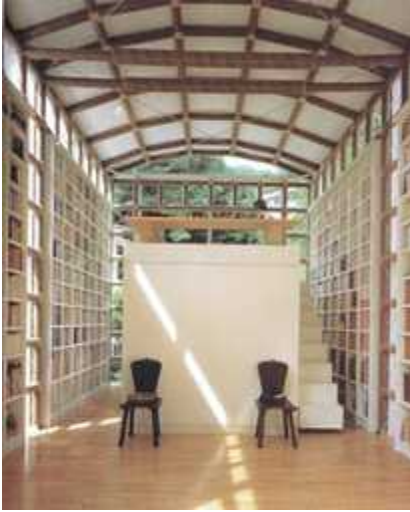
그림 36 Library of a Poet(1991), 격자형 구조 패턴의 예. 본 프로젝트에서 활용된 격자형의 패턴은 구조의 보다 높은 안정성을 확보함과 동시에, 서재의 서고와의 시각적 연계를 유도한다.
