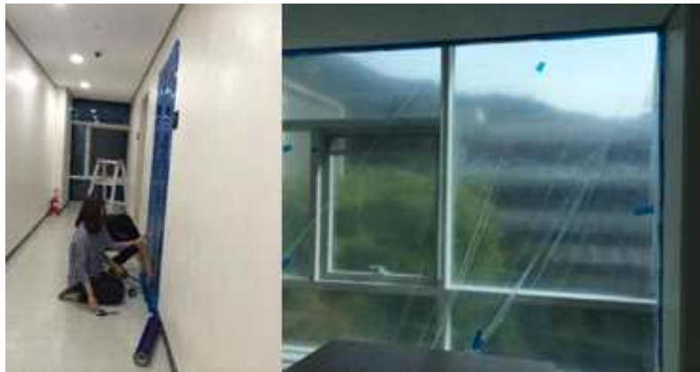
[그림 3.8] 건물 구성요소 기밀화 작업
