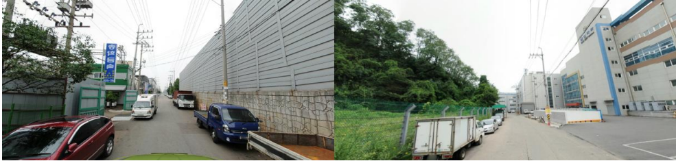
[그림 10] 개별운영과 집단화의 차폐시설 비교 (좌: 기존 산업단지의 차폐시설, 우: 안산에코그린센터의 차폐시설)
