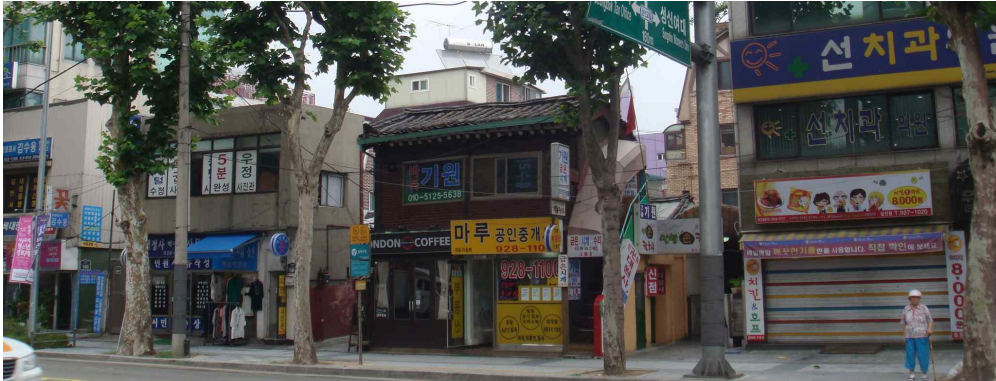
[그림3-31] 돈암지구 내 위치한 2층 한옥상가
