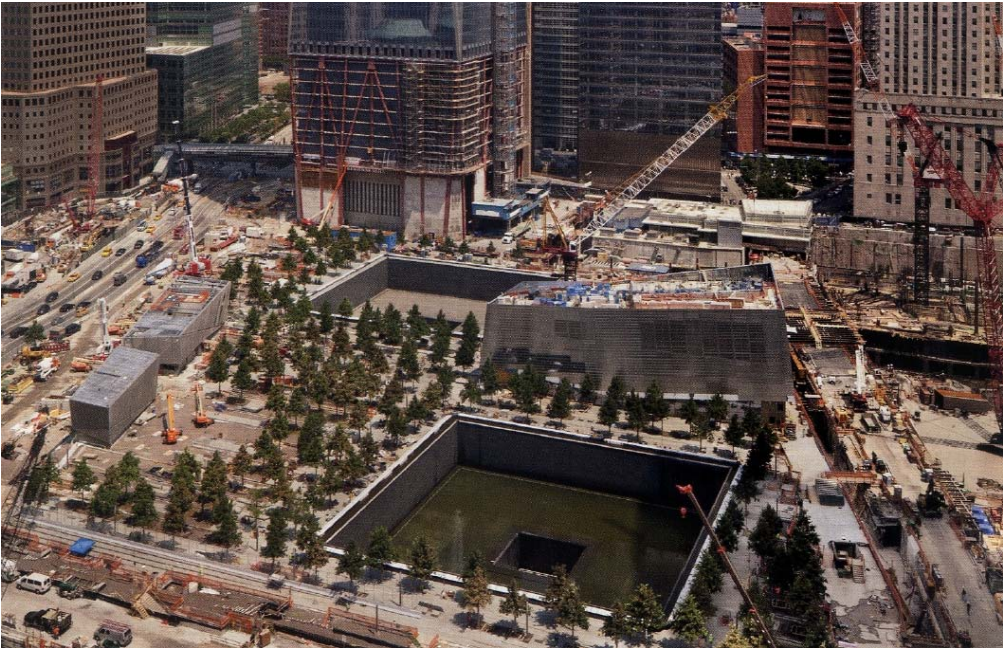
[그림 3-74] 그라운드 제로 공사현장 (2011.09) 출처 : Architectural Record 2011.09
