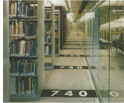
[그림 3-33] 북 스파이럴의 경사. 전체적으로 3/100의 경사로 설계되었으며, 사진에서 검은색 바닥 부분은 1/12, 회색 부분의 경사는 2/100 다. 이는 도면에서 확인할 수 있다(하단 도면). 서가를 놓는 부분은 평평한 바닥이다.(상단 도면) (출처 : 도면은 OMA, 사진은 Domus)
