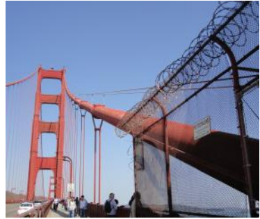
〈사진 10〉 교량 위 자살방지시설
